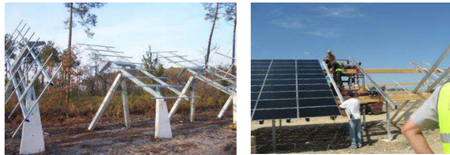
Figure 29 : Montage des supports de la technologie « trackers » (à gauche), montage de modules sur des supports fixes (à droite) Source : EDF Renouvelables
