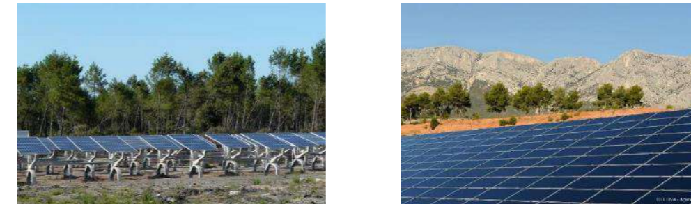
Figure 13 : Structures solaires (à gauche: les trackers de la centrale de Gabardan (40) qui suivent le soleil ; à droite : structures fixes à Puylobier (13))
